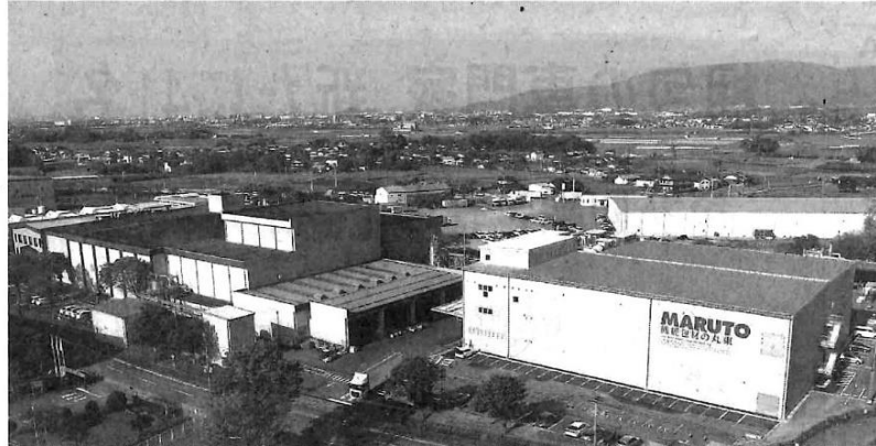
稼働を始めた福岡第二工場の外観（写真右の建物）
